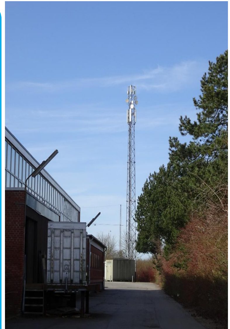
KK1 + CC2 Selvbærende gittermaster placeret i bebygget område, med lav risiko for skade, f.eks. som illustreret ved parkeringsplads i industriområde, eller ved siden af en gård.
