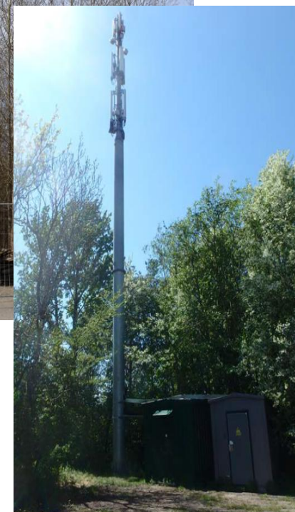
KK1 + CC1 Monopole, Rørmaster eller stålskorstene der ved svigt IKKE kan kollideres med bebyggelse eller større færdselsårer/ befærdede områder, f.eks. som illustreret ved en monopole ved en øde opbevaringsplads eller i kanten af et bevokset areal.
