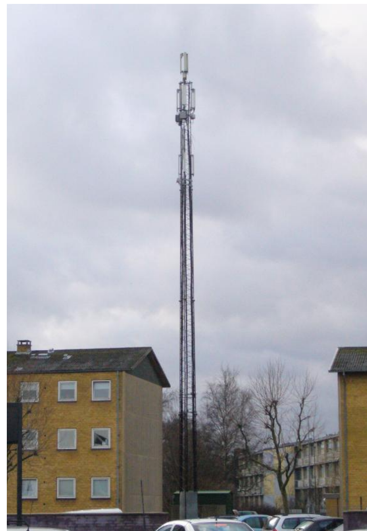
KK2 + CC2 Selvbærende gittermaster placeret i bebygget område, hvor masten kan kollidere med daginstitutioner eller undervisningsbygning eller 3-etagers boligejendom eller større færdselsårer/ befærdede områder, f.eks. som illustreret ved en mast, der er placeret imellem boligblokke på flere etager.
