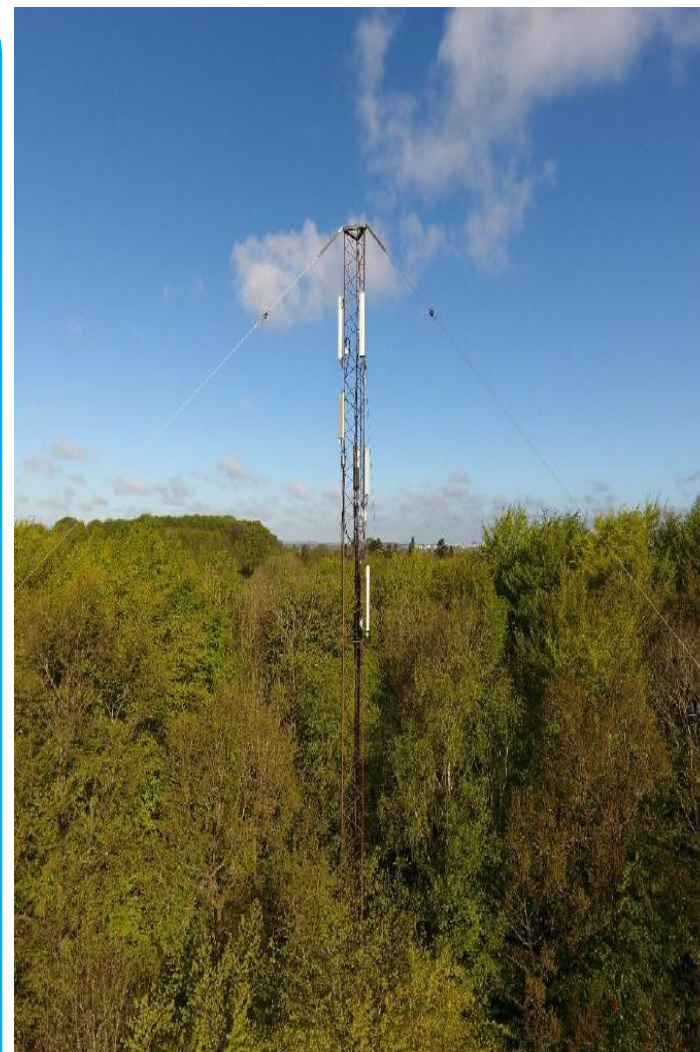
KK1 + CC1 Bardunerede master der ved svigt IKKE kan kollideres med bebyggelse eller større færdselsårer/ befærdede områder.
