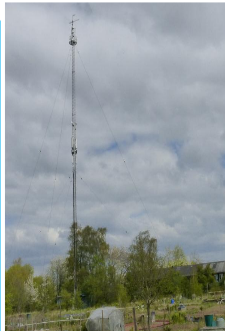
KK2 + CC2 Bardunerede master der ved svigt kan kollidere med bebyggelse svarende til enfamiliehus, rækkehus, 1-etagers lager-, industri-, avls- og driftsbygninger, større færdselsårer eller befærdede områder.
