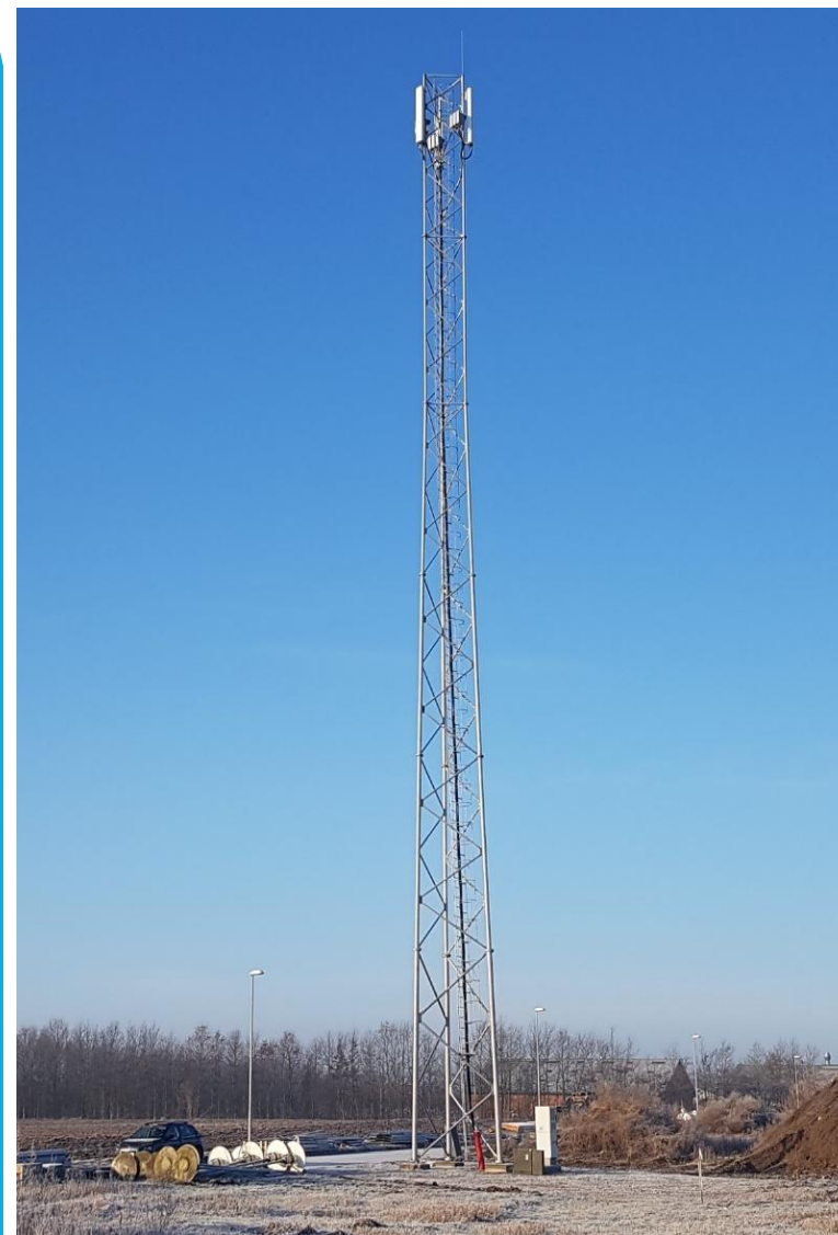
KK1 + CC1 Selvbærende gittermaster der ved svigt IKKE kan kollideres med bebyggelse eller større færdselsårer/ befærdede områder.
