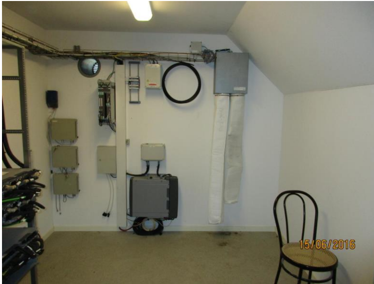
Figur 1 – Teleudstyr placeret i eksisterende teknikrum
