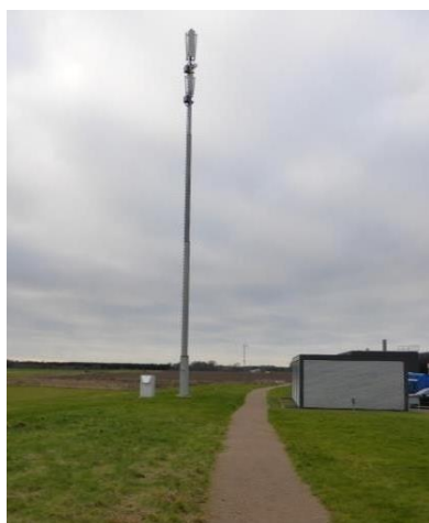
Figur 3 – Rørmaster
