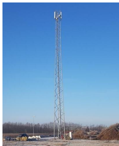
Figur 2 – Fritstående gittermaster
