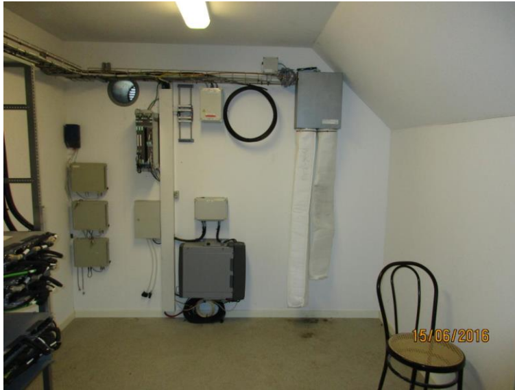
Figur 3 – Teleudstyr placeret i eksisterende teknikrum
