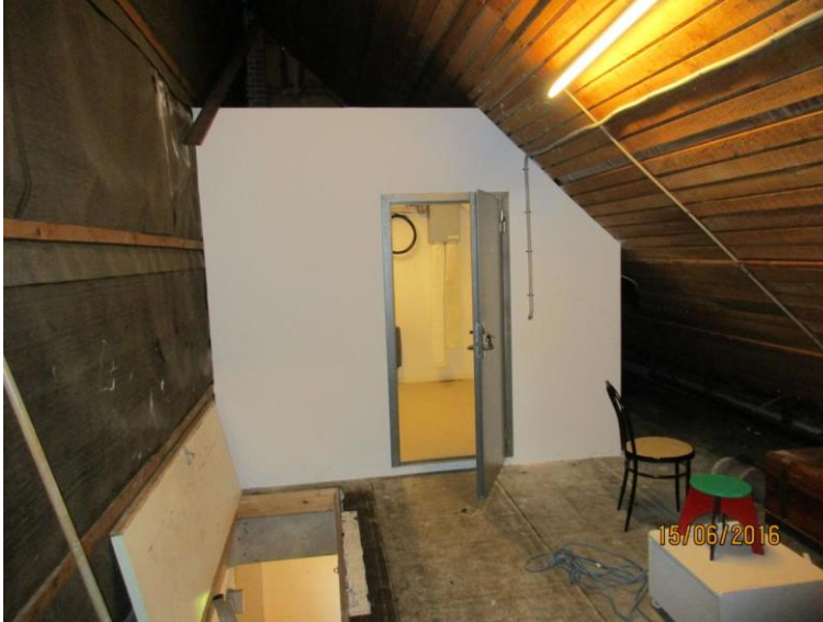
Figur 2 – Nyindrettet teknikrum etableret i eksisterende bygning
