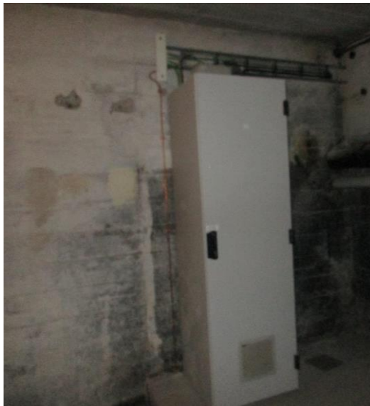
Figur 1 – Teknikskab placeret indeni bygning
