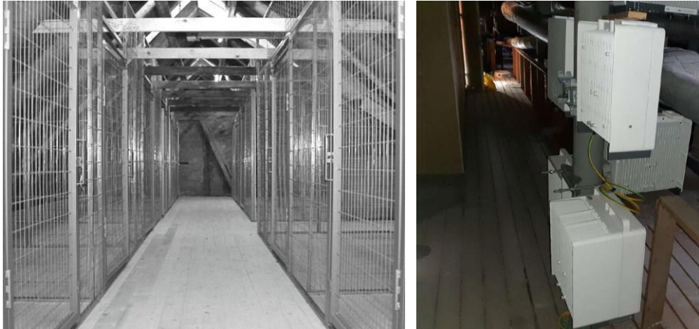
Figur 1 – Teleudstyr placeret i udnyttet tagrum, tagrum med depotrum eller pulterrum
