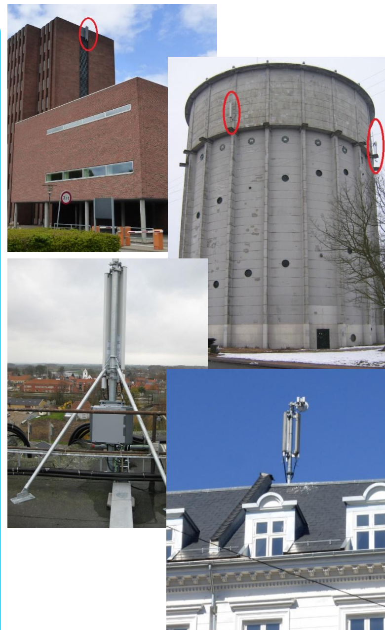
KK1 + CC1 Bydækker med lav risiko for betydelig svigt kan f.eks. være antenne på facade eller små fritstående bærerør af typen Tri-pod med god fastholdelse.
