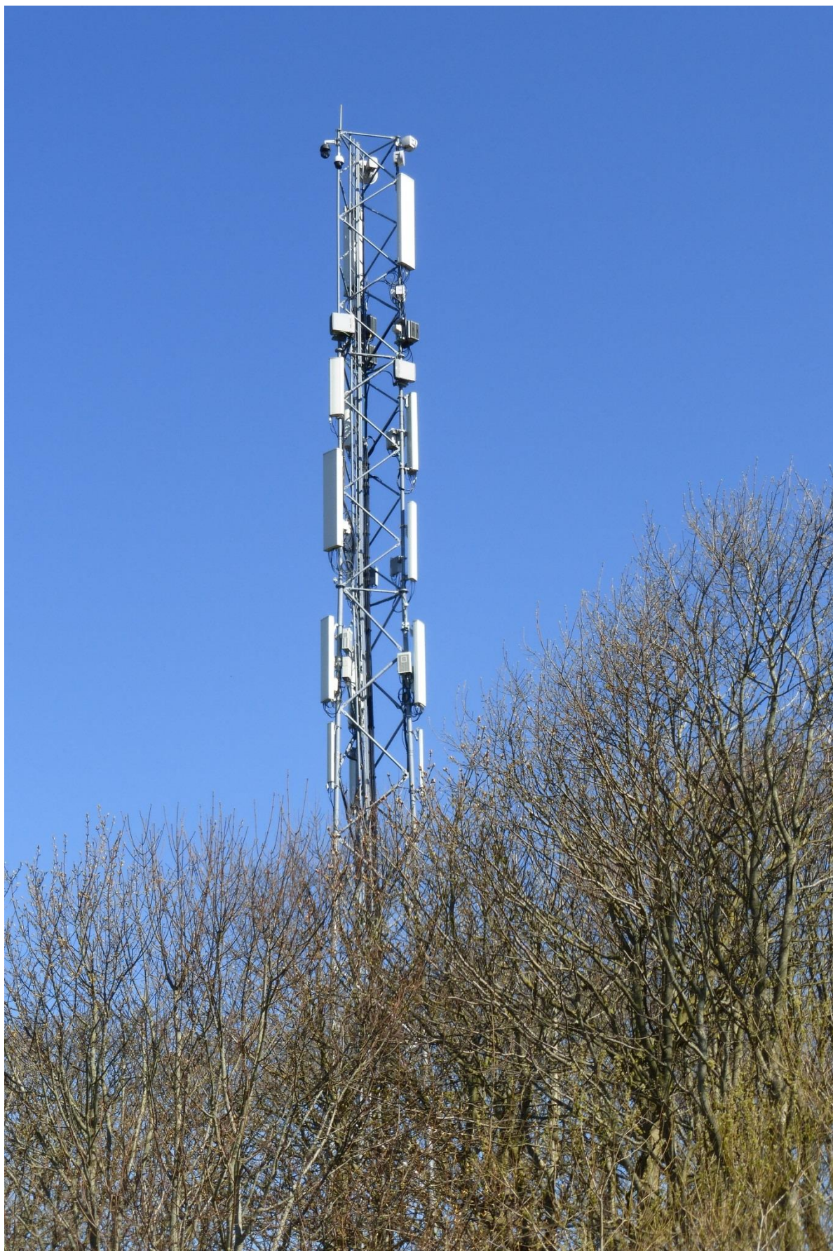
Antenner på mast
