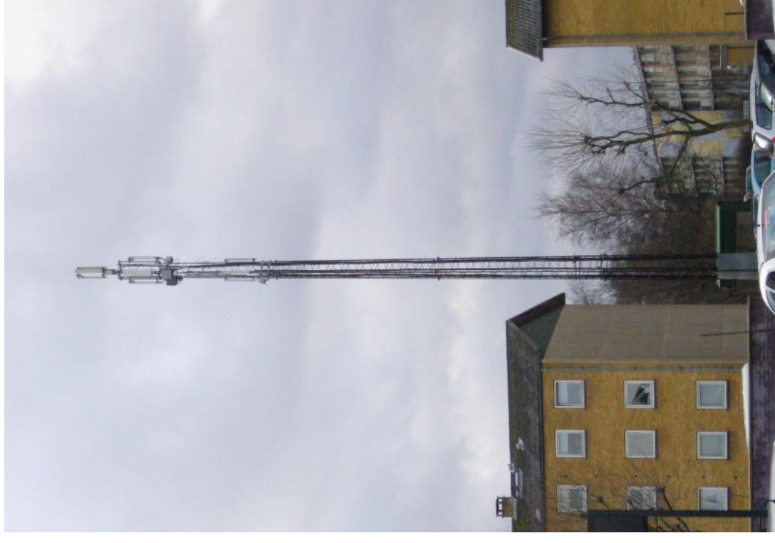
KK2 + CC2 Selvbærende gittermaster placeret i bebygget område, hvor masten kan kollidere med bebyggelse (beboelse) eller større færdselsårer/ befærdede områder, f.eks. som illustreret ved en mast, der er placeret imellem boligblokke.
