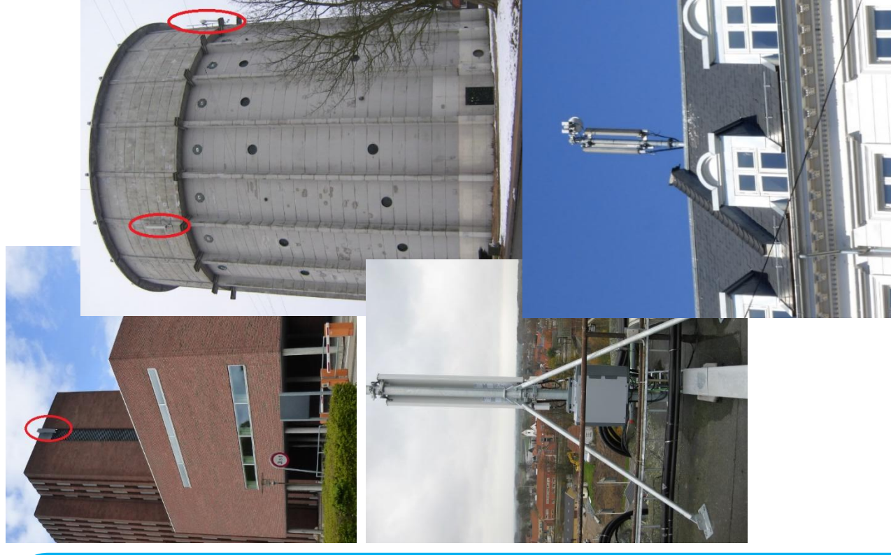
KK1 + CC1 Bydækker med lav risiko for betydelig svigt kan f.eks. være antenne på facade eller små fritstående bærerør af typen Tri-pod med god fastholdelse.
