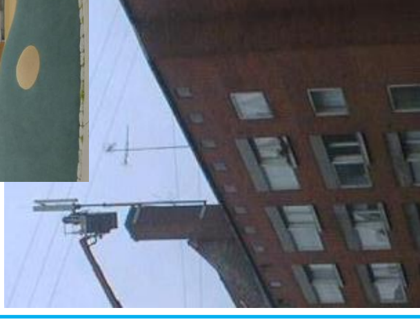
KK2 + CC2 Bydækker i KK2-CC2 kan f.eks. være antenne placeret på tag med radome, høje bærerør fastgjort af typen Tri-pod med god fastholdelse.
