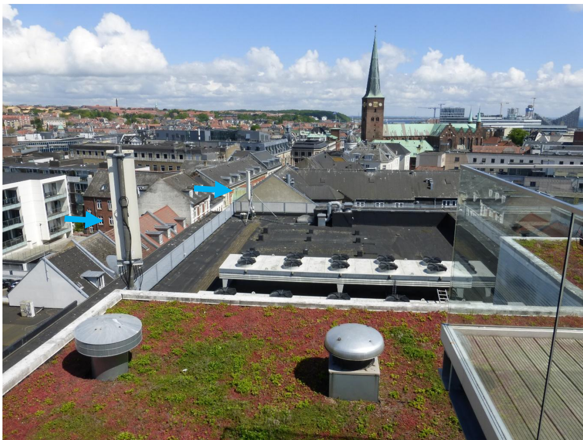
Antenner fotograferet fra gangbro ud over gaden – mod nordøst
