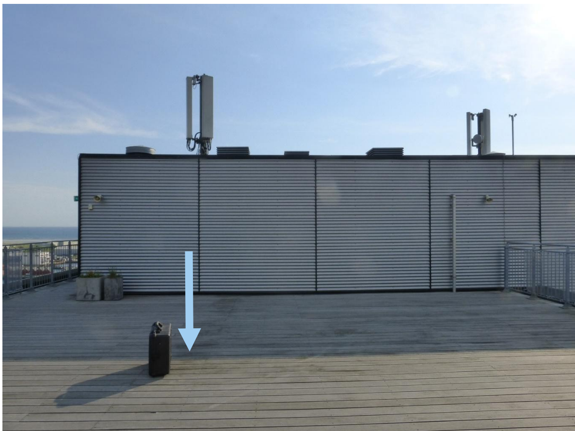
Målepunkt 1 tæt ved antennerne
