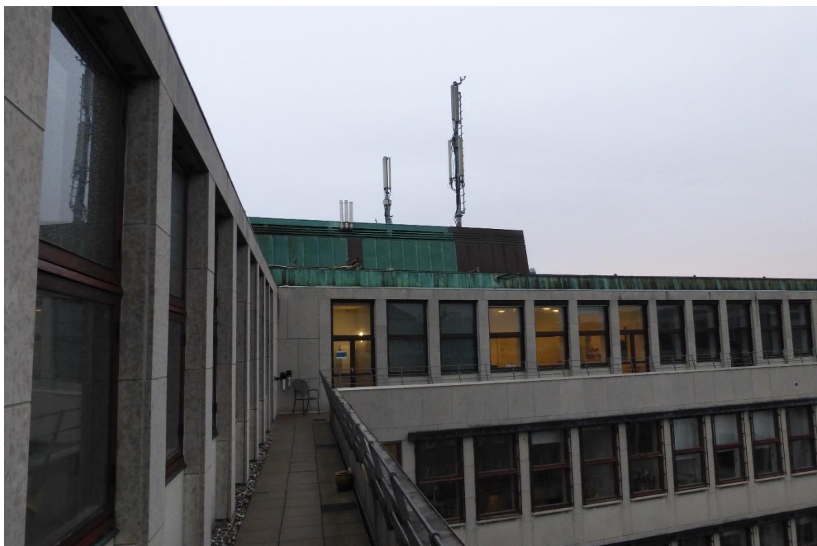
Udsigt til antenner fra målepunkt 2
