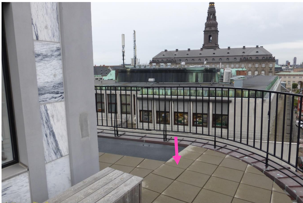
Målepunkt 5 ved hjørne på bygning på Holmens Kanal 20
