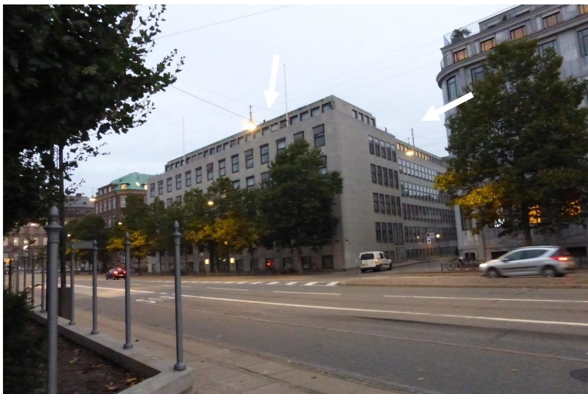
Oversigtsfoto af Holmens Kanal 22 fra sydøst. Antennerne er opsat på bærerør inde på taget.
