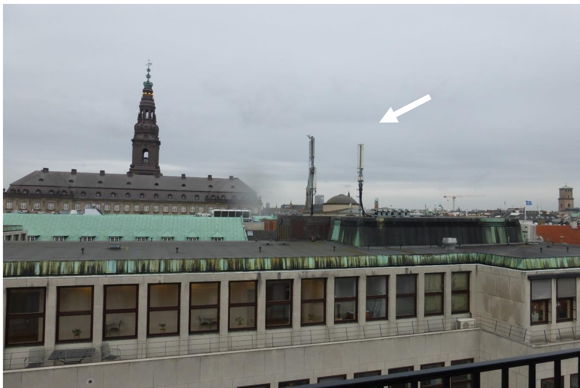
Nogle af antennerne på Holmens Kanal 22 set fra Holmens Kanal 20.
