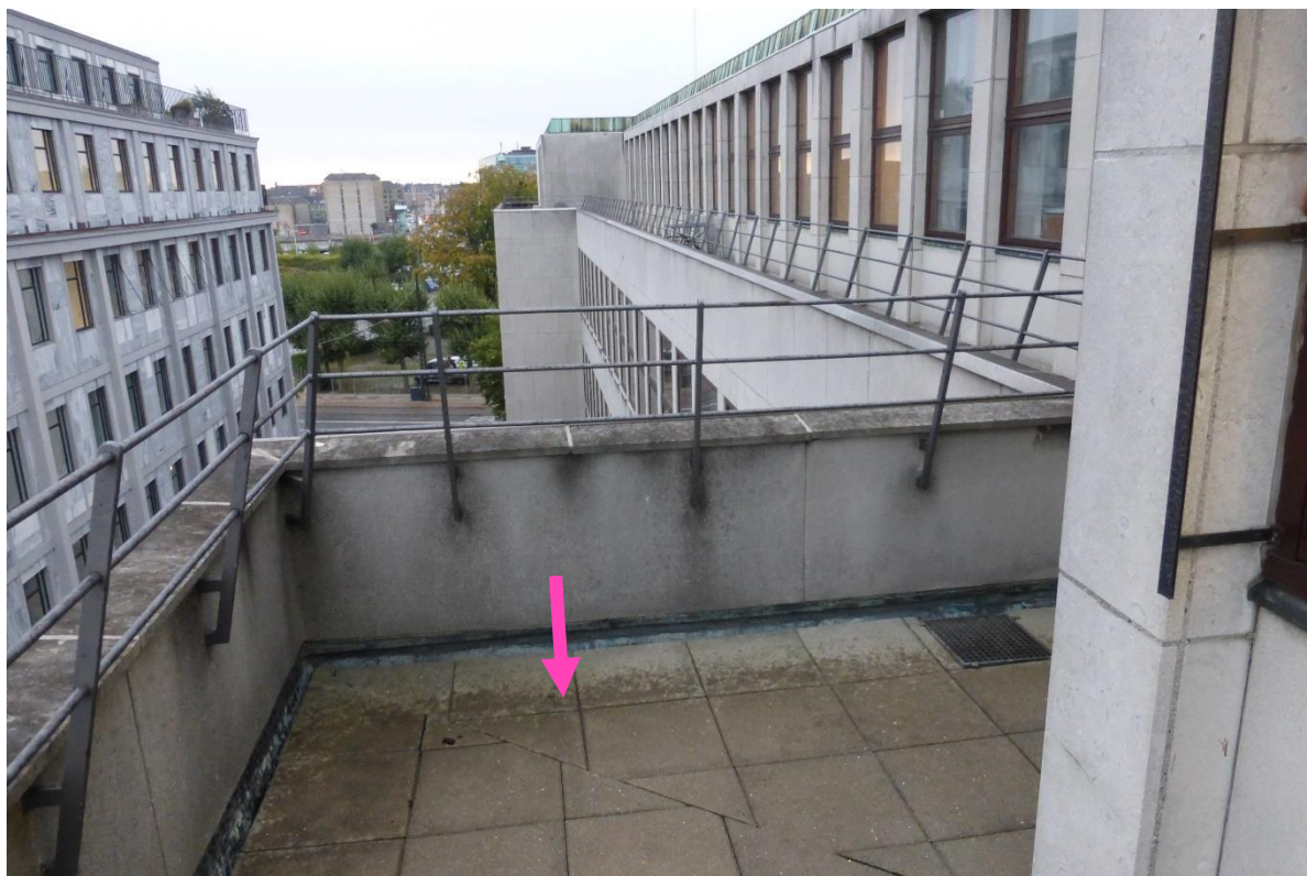
Målepunkt 3 på ved knæk på østsiden af bygning på Holmens Kanal 22
