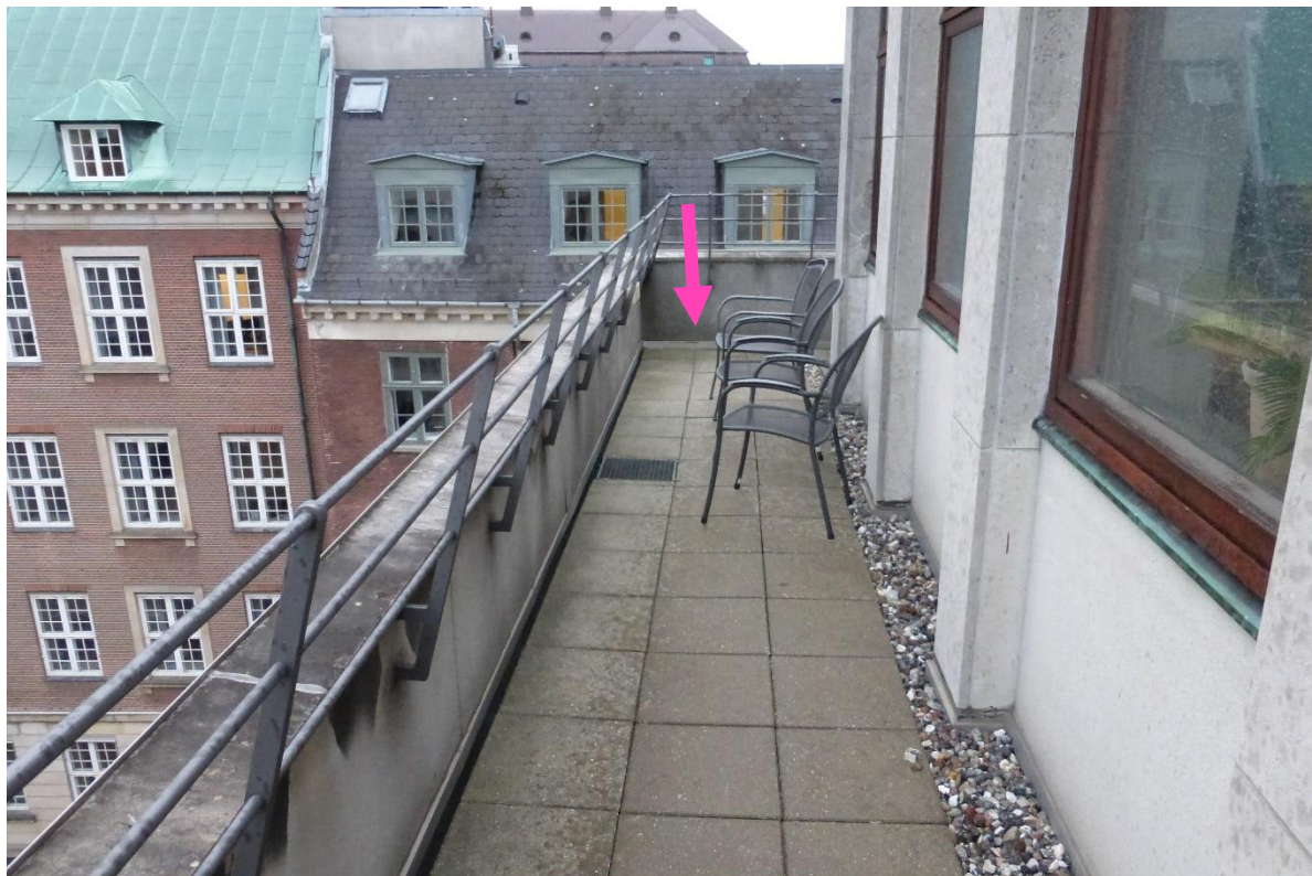
Målepunkt 2 ved hjørne på Holmens Kanal 22
