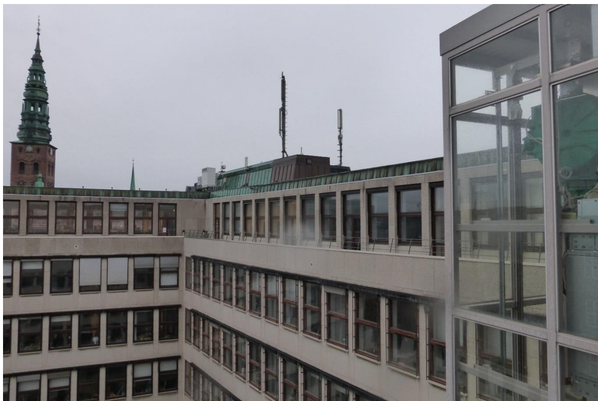
Udsigt til antenner fra målepunkt 4
