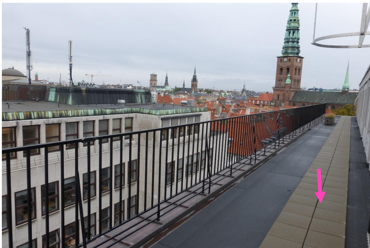
Målepunkt 6 ved hjørne på bygning på Holmens Kanal 20
