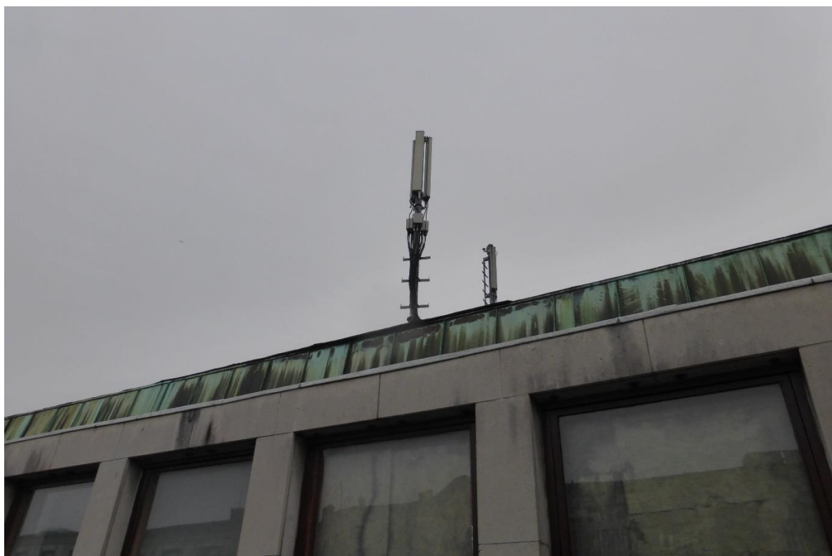
Udsigt til antenner fra målepunkt 3
