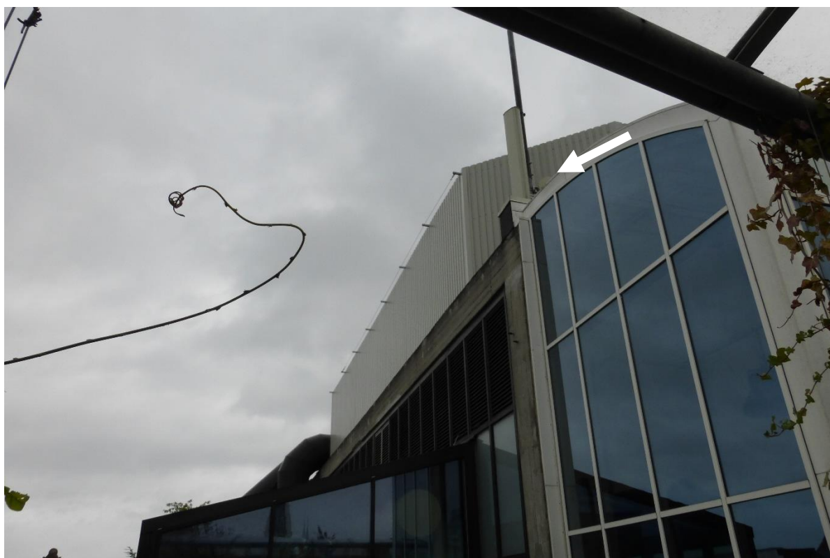
Oversigtsfoto fra målepunkt 3 – antenne på facaden øverst – mod nord.
