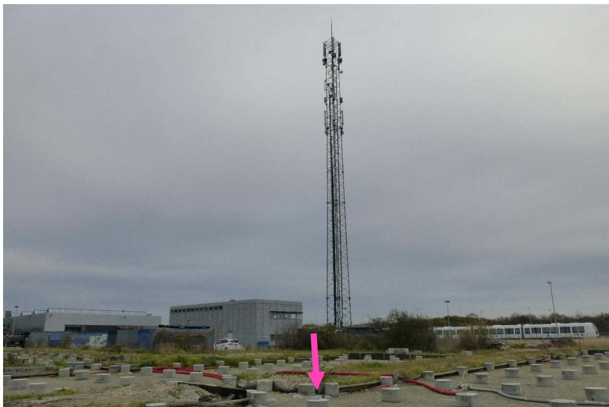
Målepunkt 5 ved fundamenter
