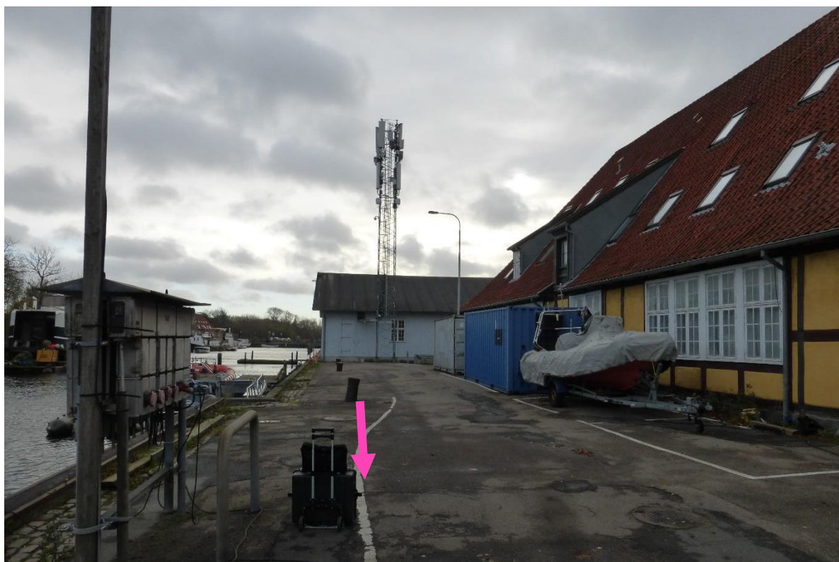
Målepunkt 2 mod nord ved strømudtag
