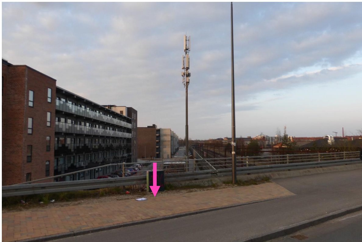
Målepunkt 4 ved lysmast på vej ved krydsning jernbane - vej
