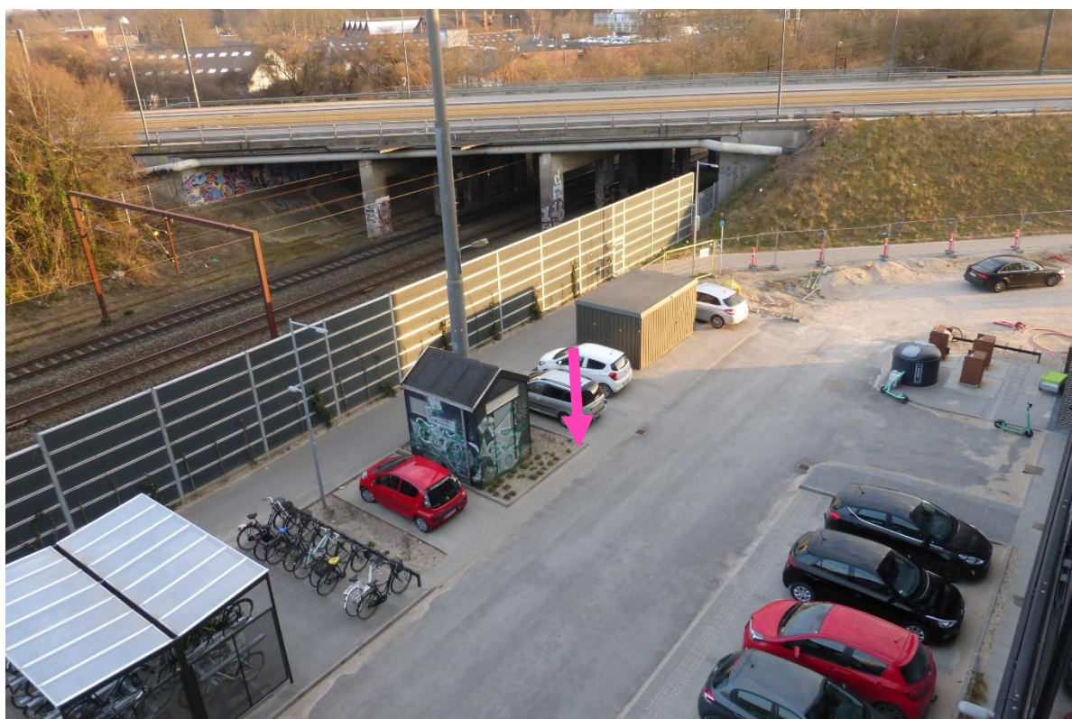
Målepunkt 3 på terræn ved kabine
