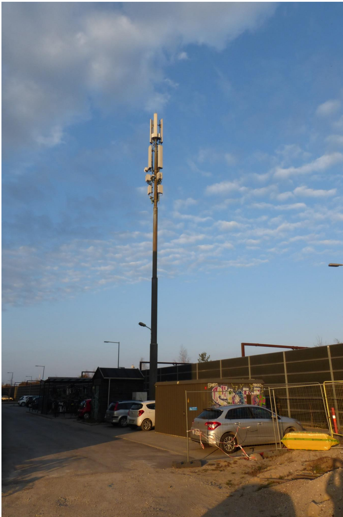
Foto af konstruktion med antenner set fra syd
