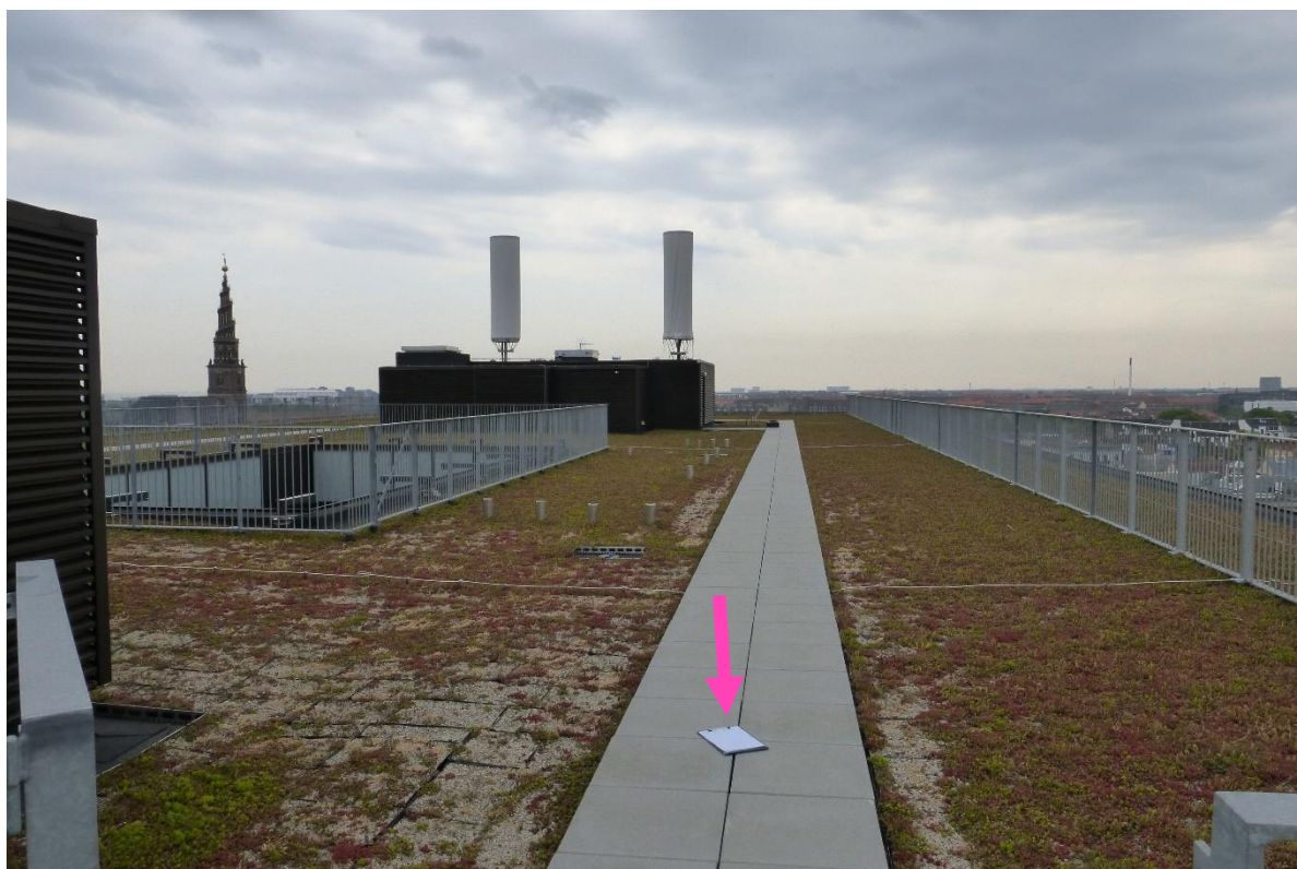
Målepunkt 3 på tagfladen ved første nordlige teknikhus på vestsiden
