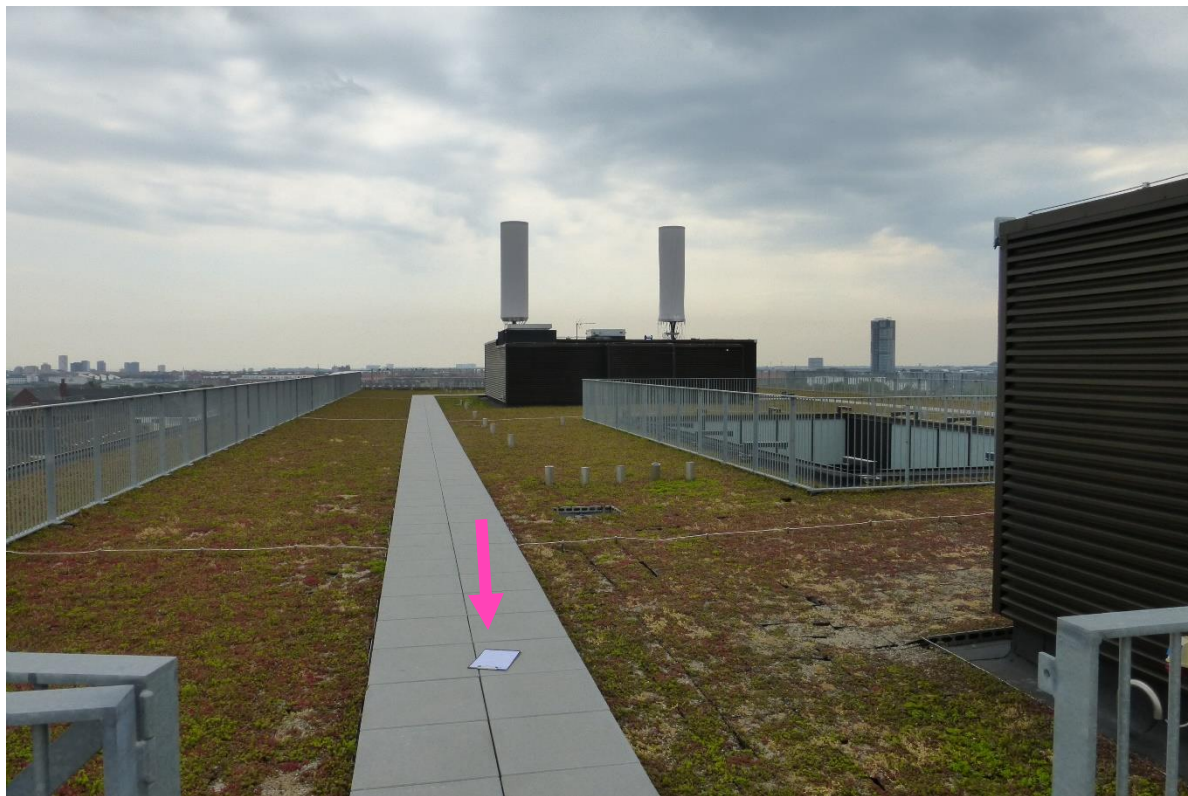
Målepunkt 4 på tagfladen ved første nordlige teknikhus på østsiden
