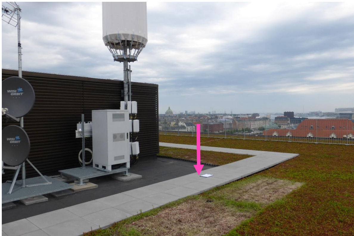
Målepunkt 2 på tagfladen ved øst rør
