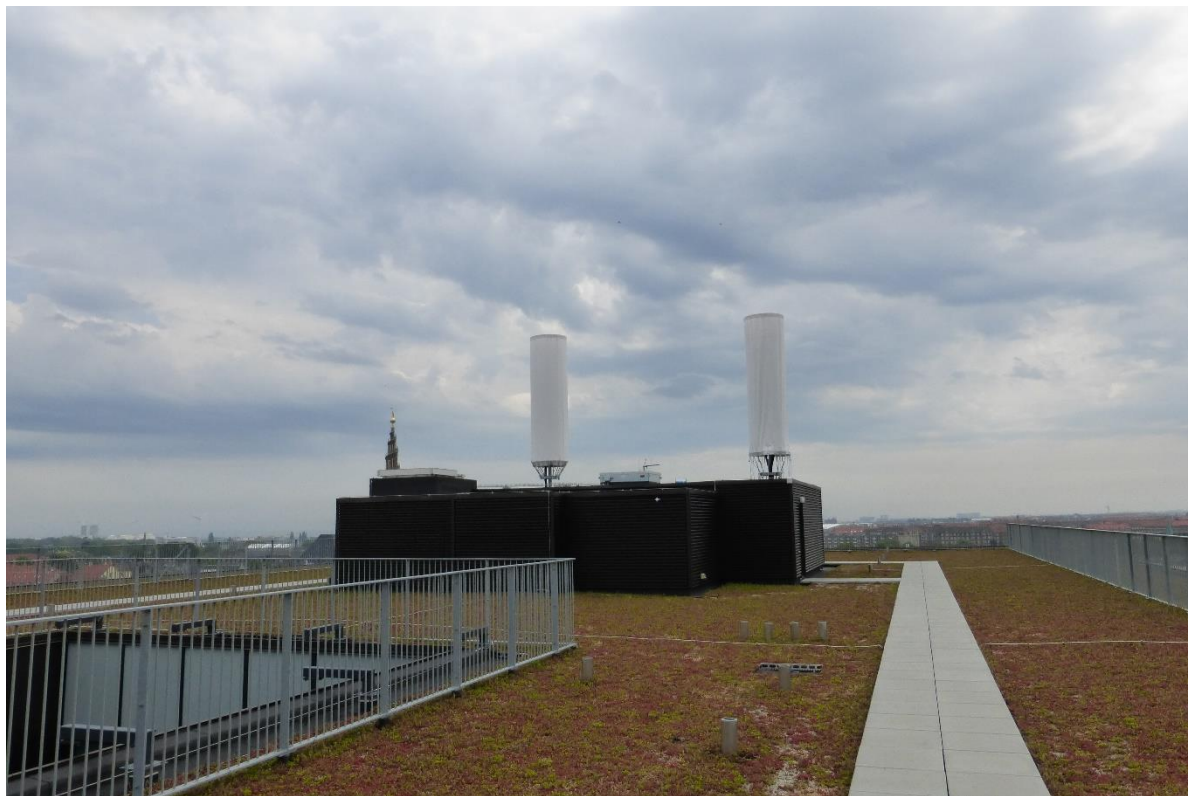
Oversigtsfoto mod sydøst – antenner er skjult bag dug på begge rør
