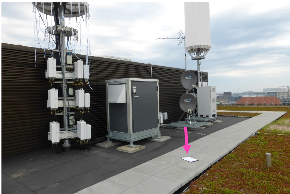
Målepunkt 1 på tagfladen nedenfor vest rør
