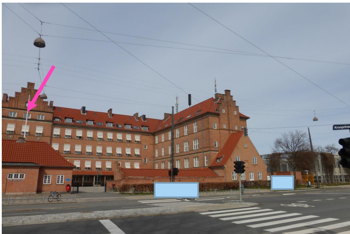
Målepunkt 1 på øverste etage ved vindue
