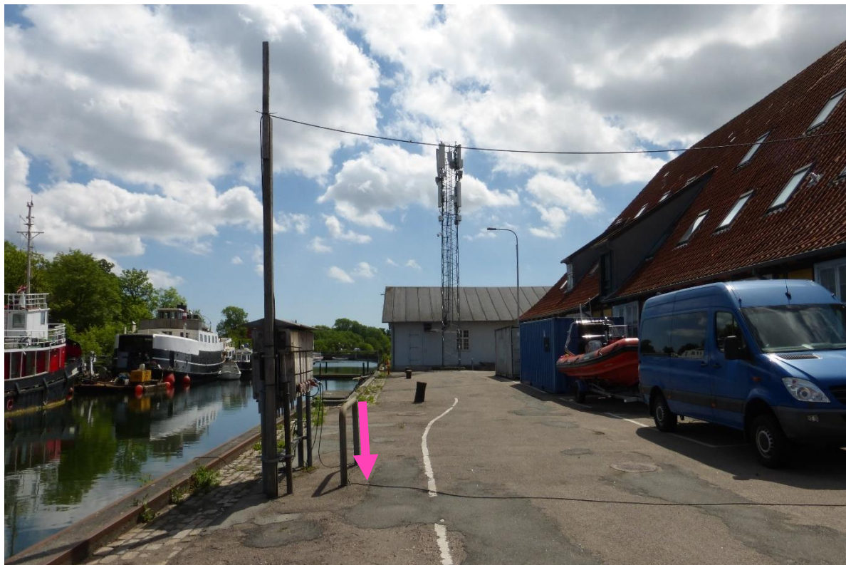
Målepunkt 2 mod nord ved strømudtag
