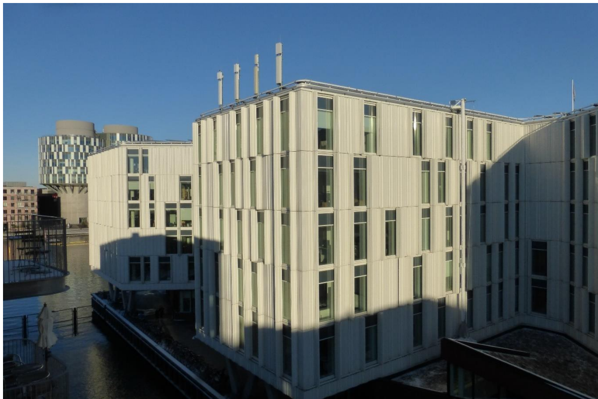
Antenner på adresse Marmorvej 51, 2100 København
