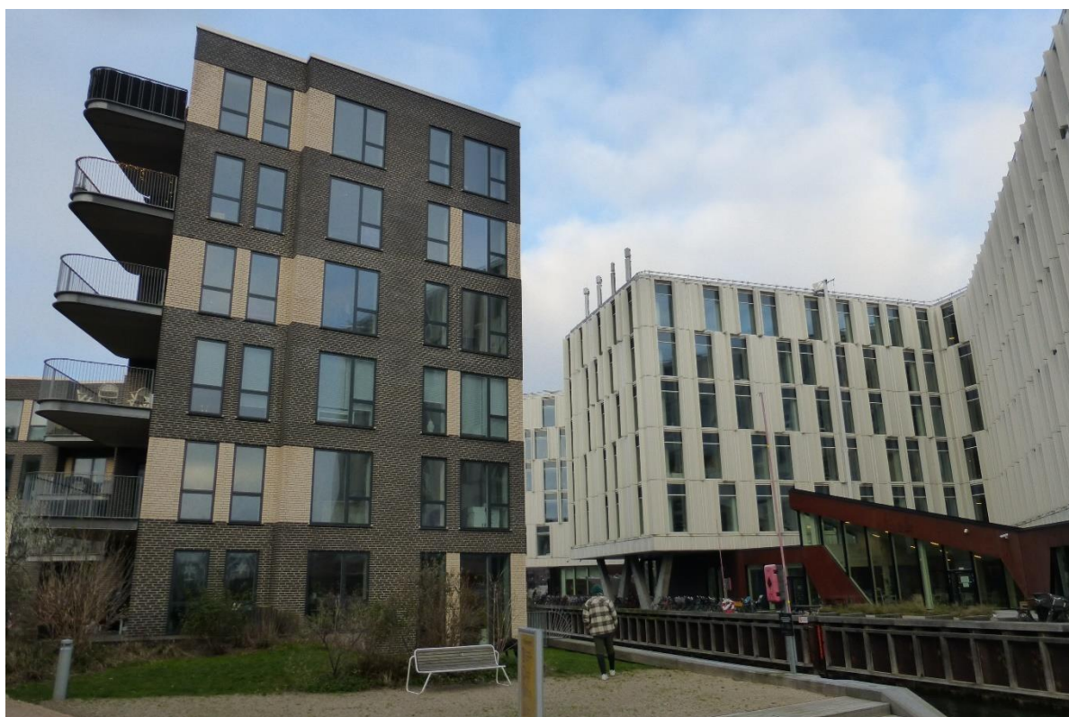
Antenner på adresse Marmorvej 51, 2100 København
