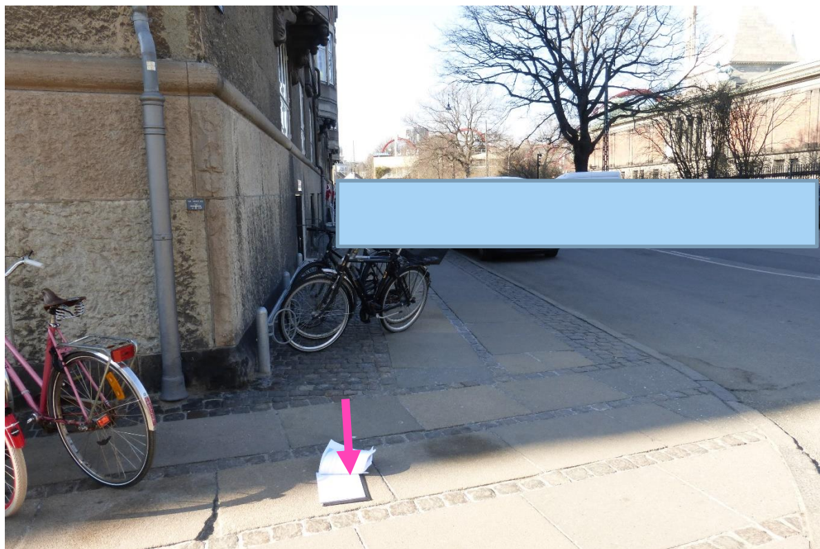
Målepunkt 10 ved bygningshjørne
