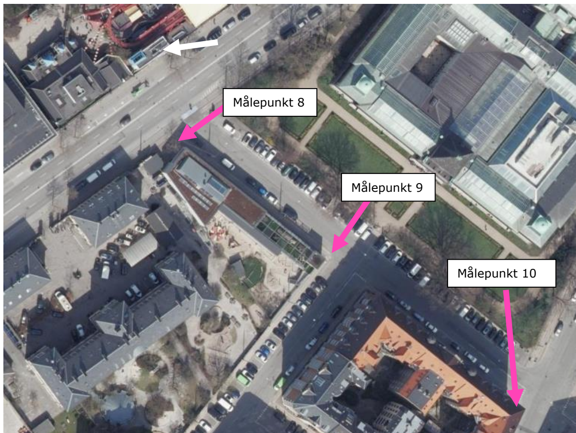
Antenner er placeret på bygning ved hvid pil
