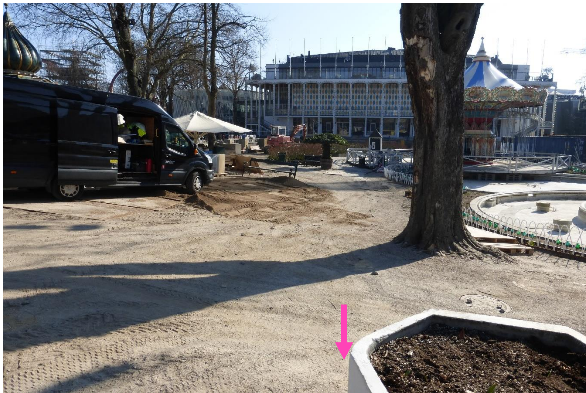
Målepunkt 5 ved betonplantekasse
