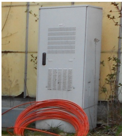
Figur 23 – Udendørs teknikskab
