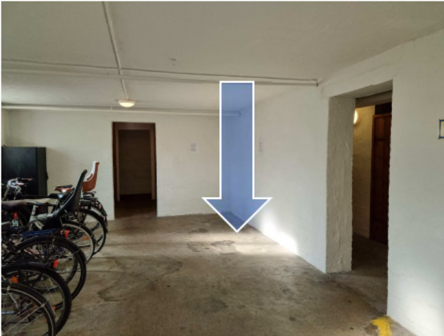
Figur 5 – Placering og montering af teknisk udstyr i cykelkælder.
