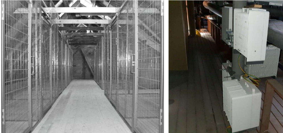
Figur 5 – Teknisk udstyr/radiotekniske komponenter placerede i udnyttet tagrum, tagrum med depotrum eller pulterrum
