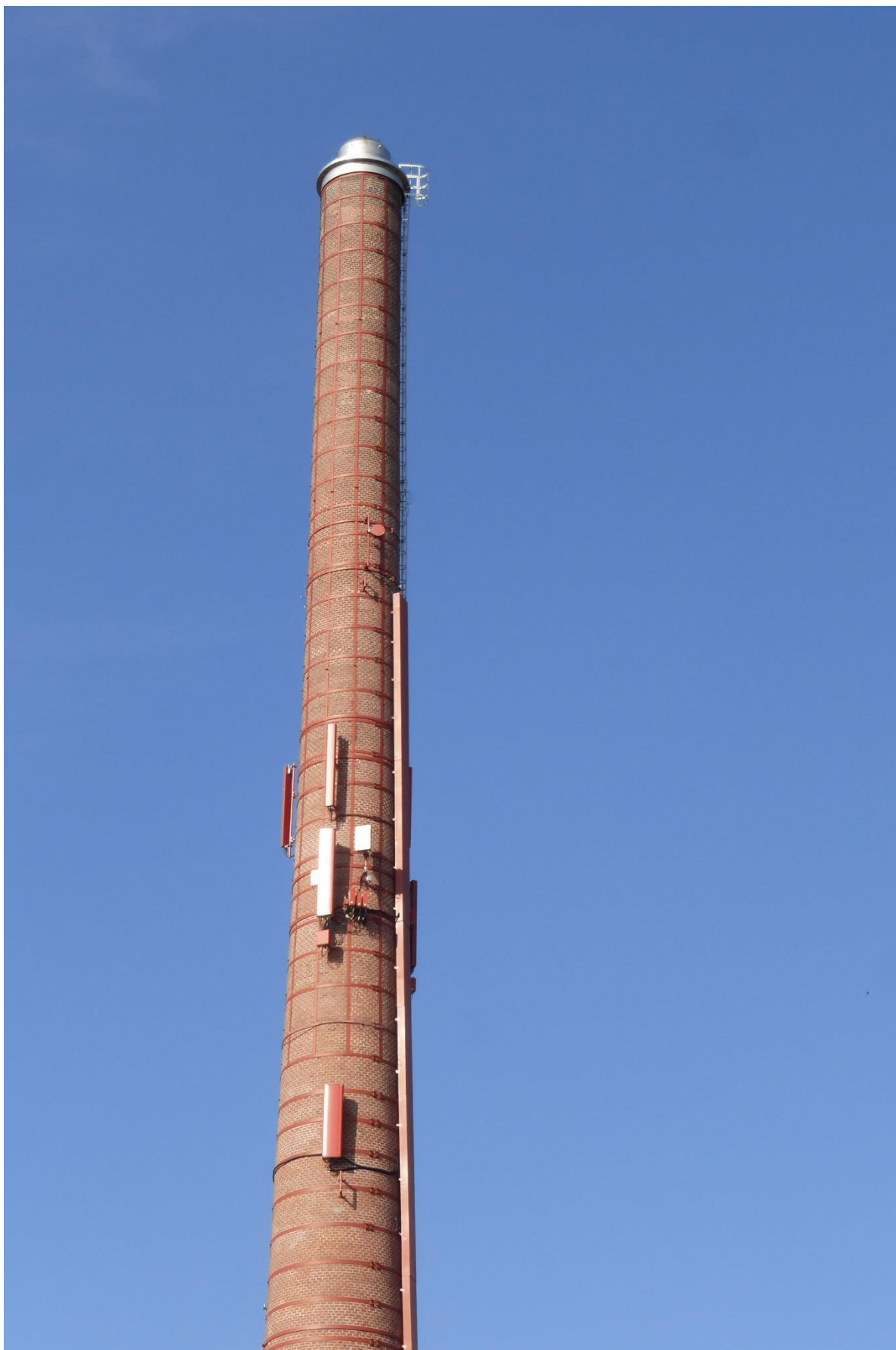
Skorsten med antenner
