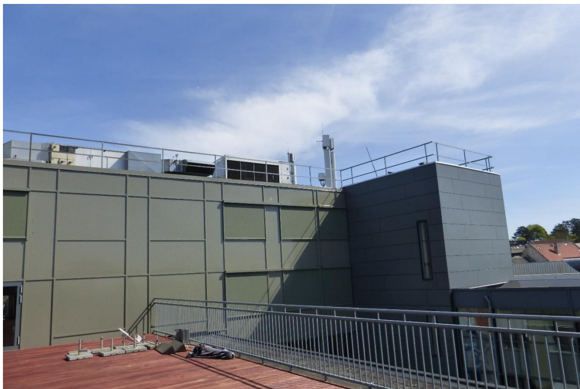
Udsigt til antenner fra målepunkt 2
