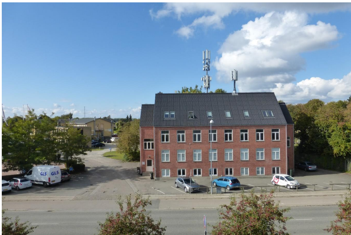
Udsigt til antenner fra Målepunkt 5
