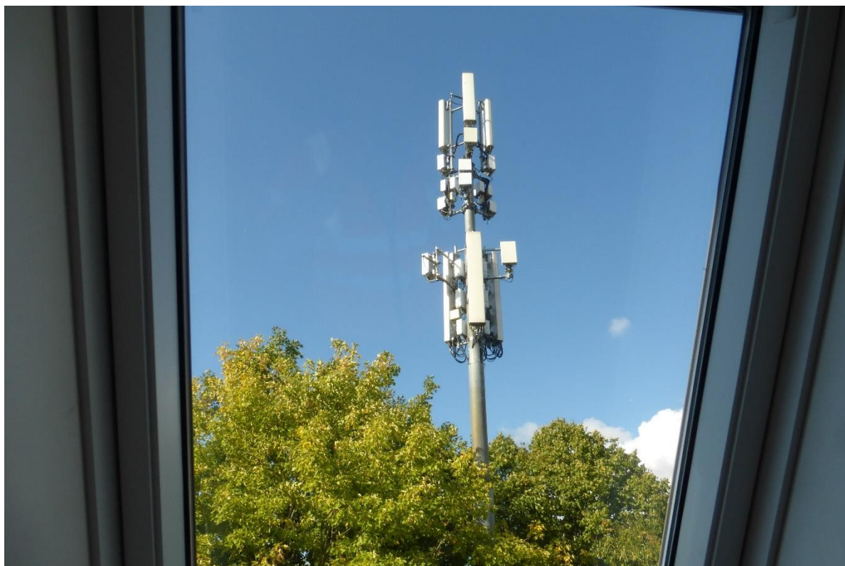
Udsigt til antenner fra målepunkt 1
