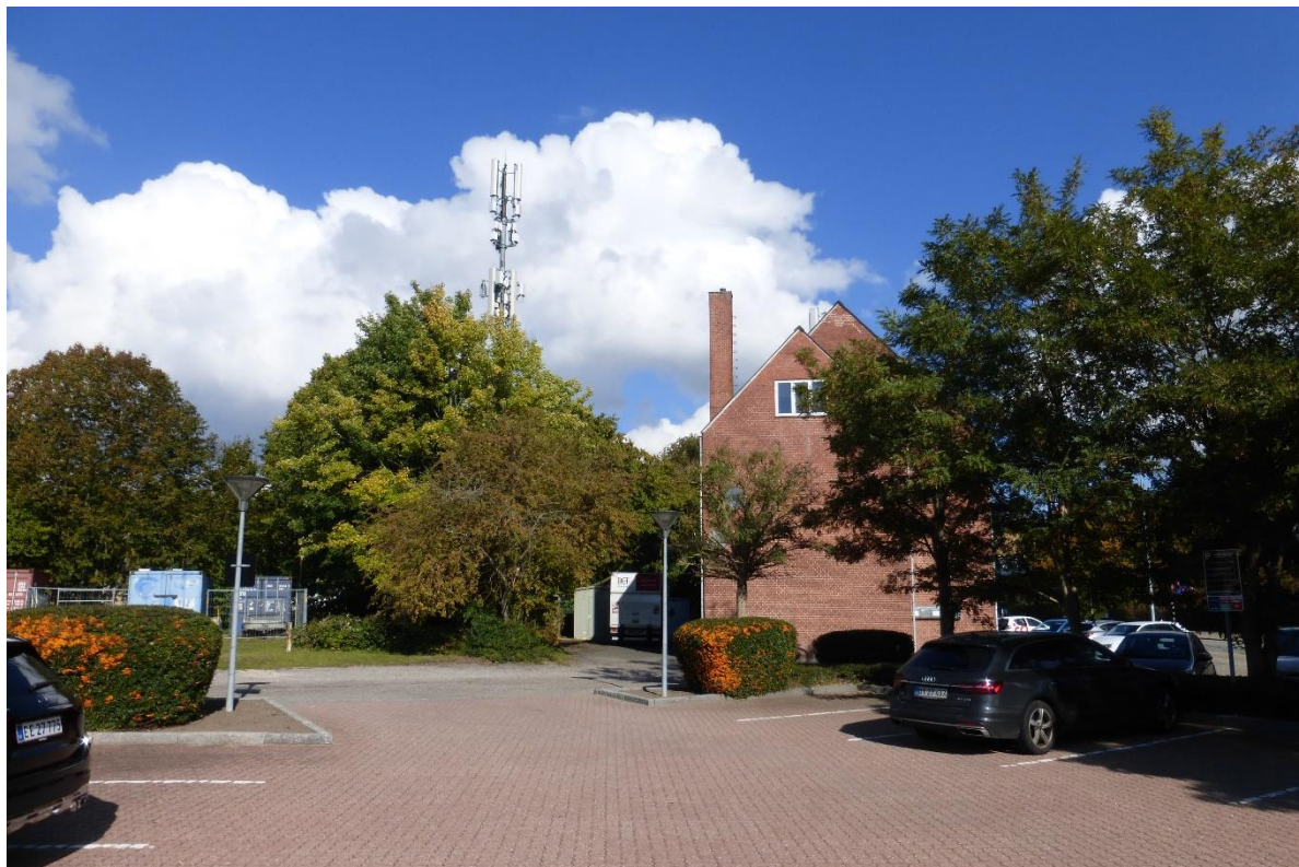
Alle operatører har antenner på ejendommen pegende ud i horisonten 120 grader forskudt.
