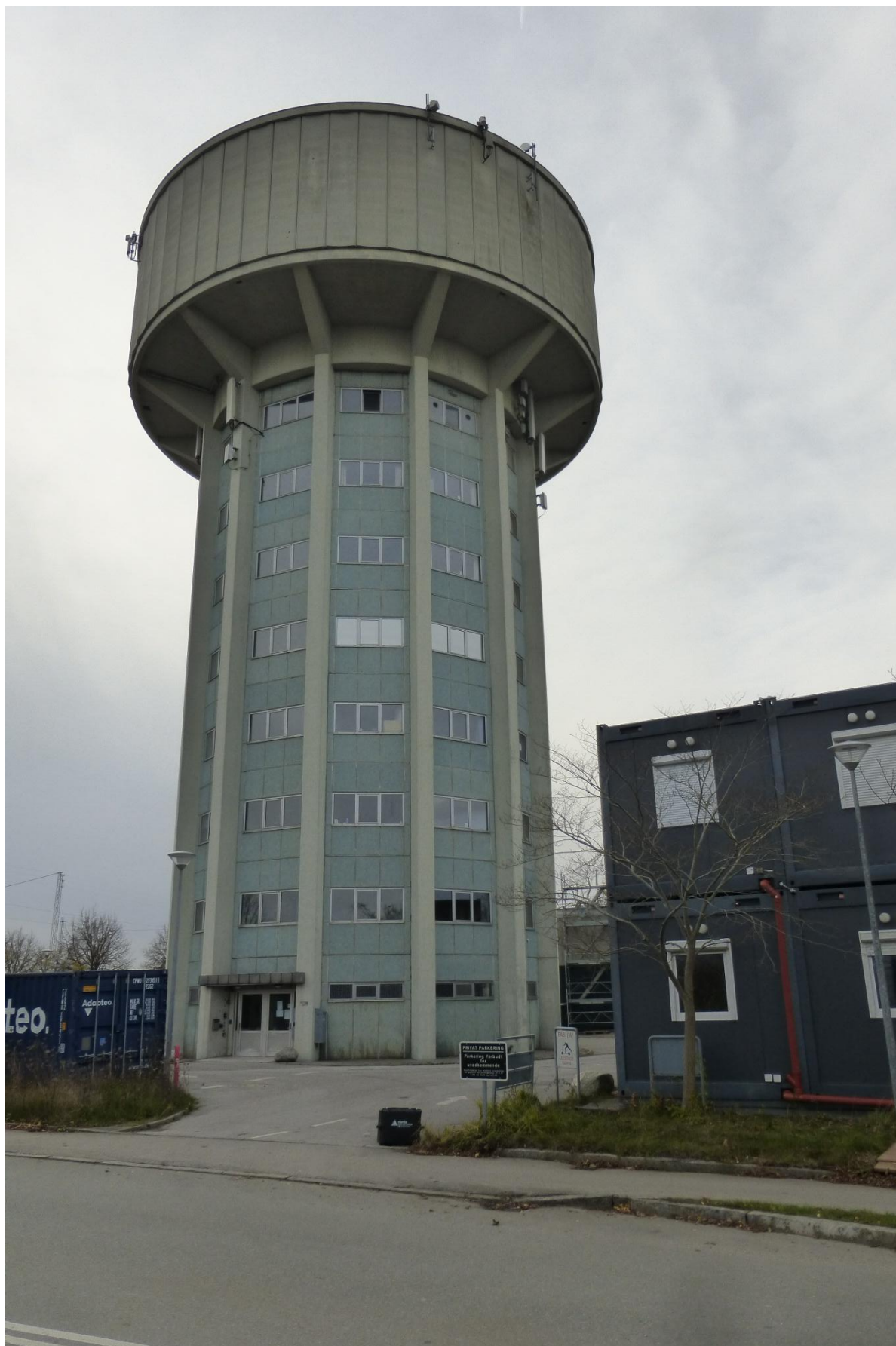
Alle operatører har antenner på vandtårnet pegende ud i horisonten 120 grader forskudt.
