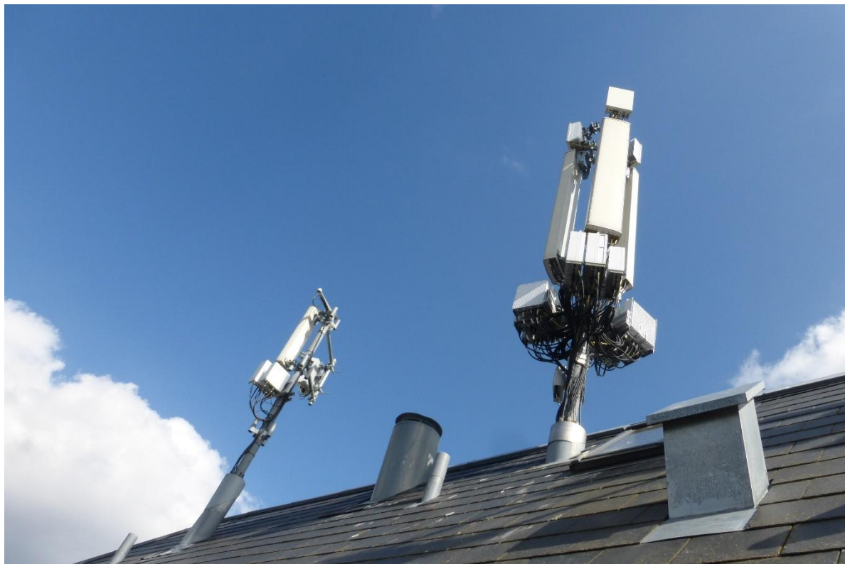
Udsigt til antenner fra målepunkt 3
