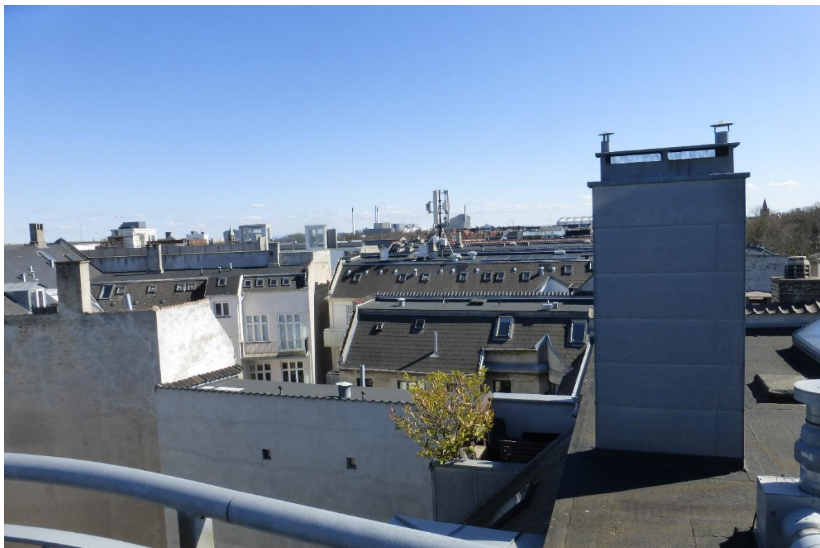
Antenner på nabobygning
