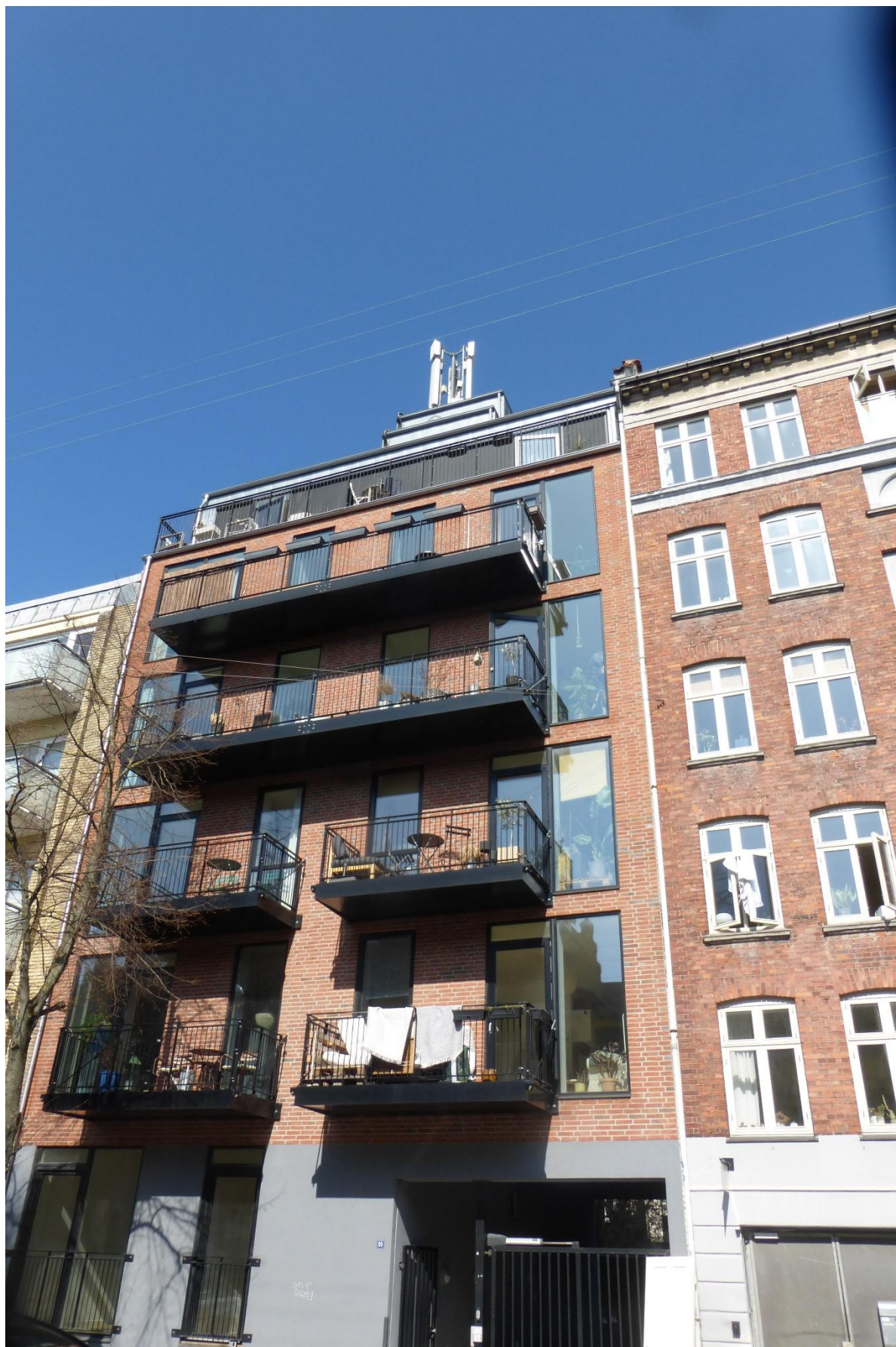
Antenner på Bjelkes Allé 20.
