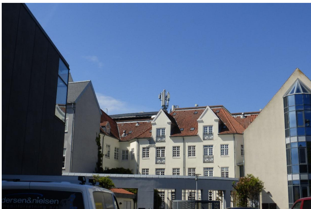
Mobilantenner på taget
