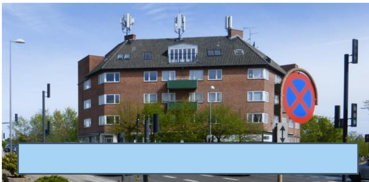
Antenner på bygningen
