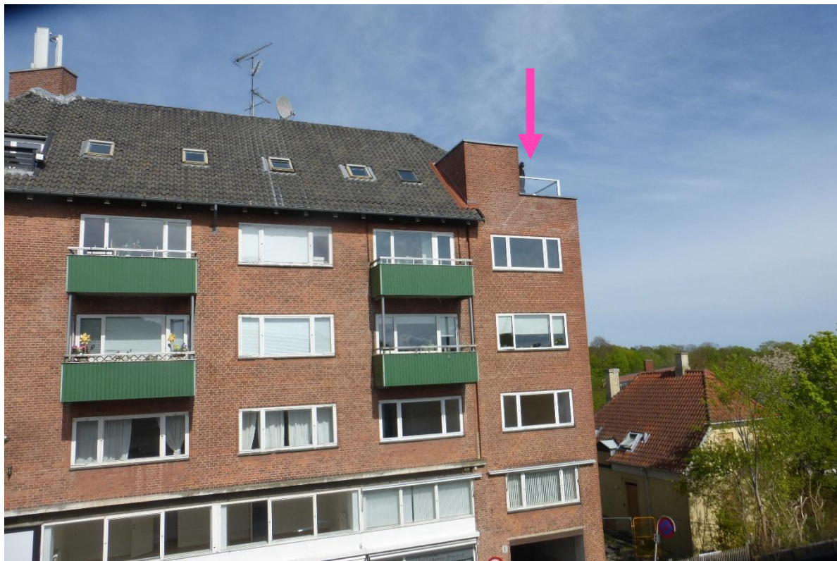
Tagterasse ved målepunkt 3 – antenner er ikke synlig fra terrassen
