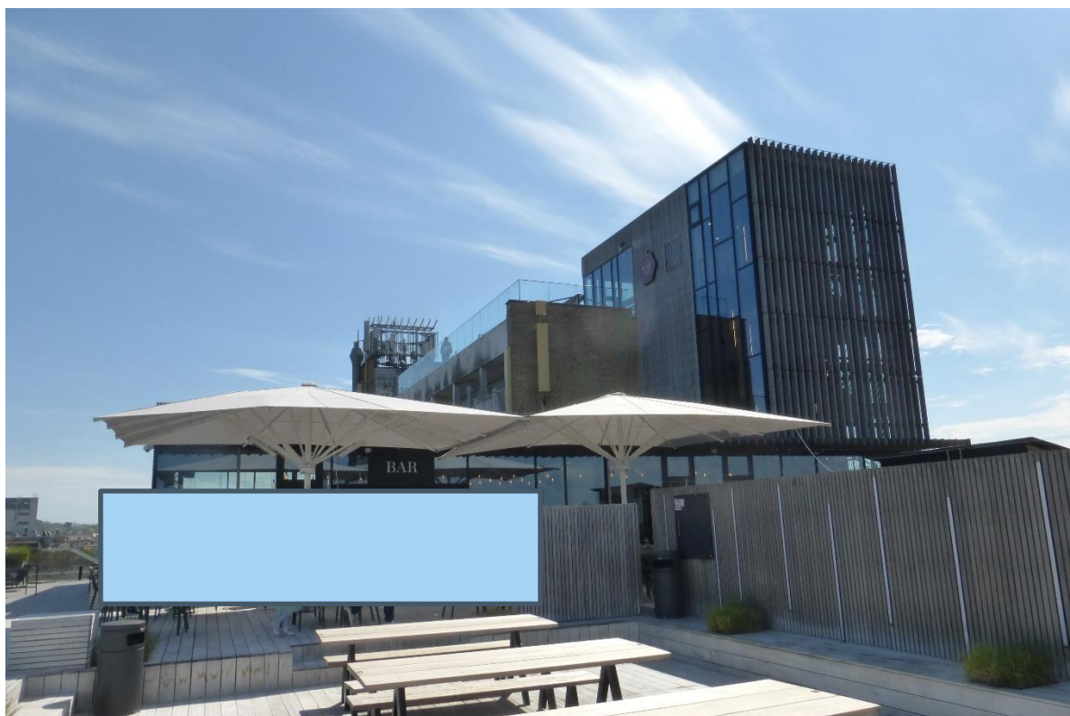
Antenner på mur
